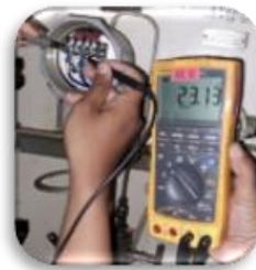
Gambar 9. Pengukuran Tegangan Pressure Switch
